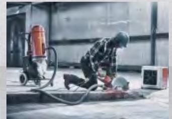
Bei nassen Trenn-/Bohrverfahren wird der Staub direkt am Entstehungsort mit Wasser gebunden. Die Vorrichtung zum Aufsammeln des Schlammes kann an einen Schlammsauger angeschlossen werden, um den Arbeitsplatz sauber zu halten.
