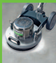
Aufarbeiten und Schleifen von Estrichböden
